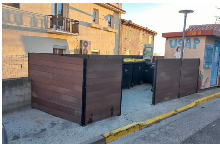
Site Rue de l'Aloès
